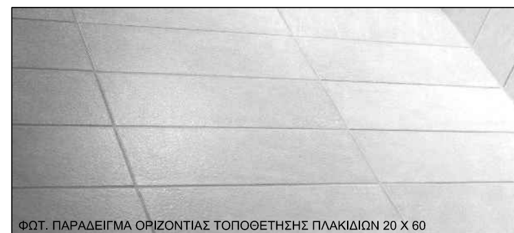
ΦΩΤ. ΠΑΡΑΔΕΙΓΜΑ ΟΡΙΖΟΝΤΙΑΣ ΤΟΠΟΘΕΤΗΣΗΣ ΠΛΑΚΙΔΙΩΝ 20 X 60
