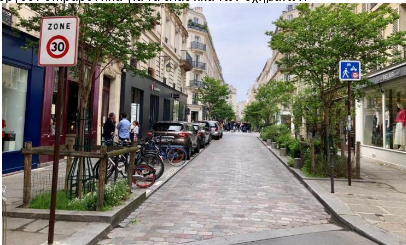
Αλλαγή υφής στο σύνολο του οδοστρώματος,
