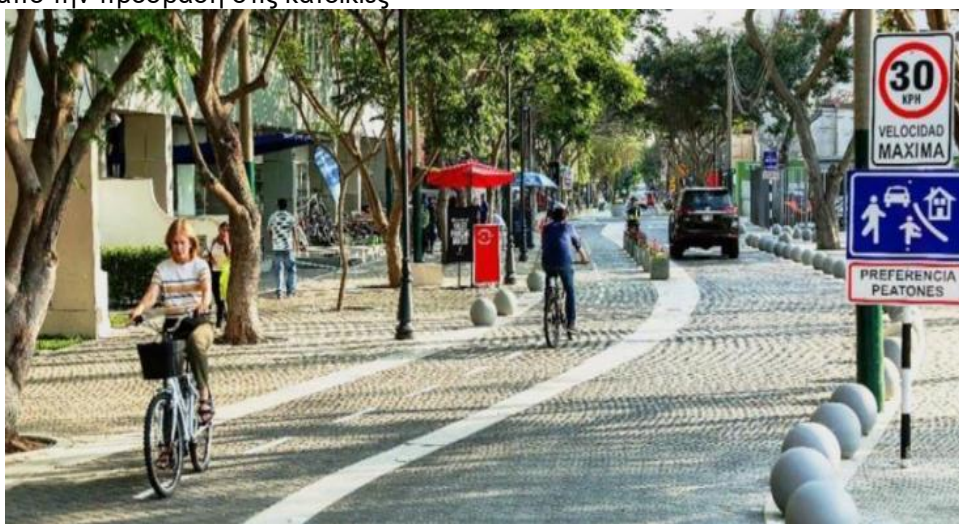
Μετατροπή οδού σε ήπιας κυκλοφορίας
